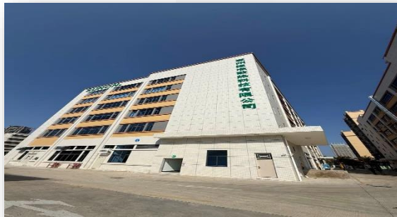
廣東惠州 (新廠) 液冷/氣冷模組
