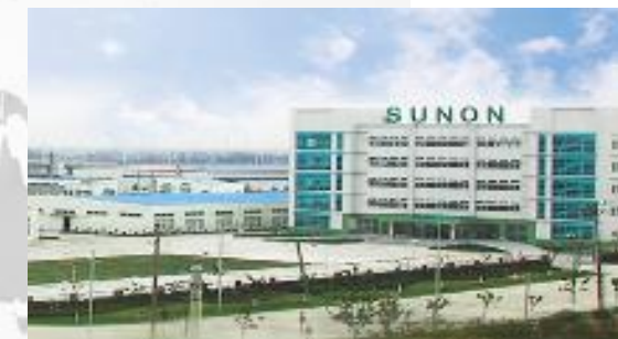
Kunshan, Jiangsu Fan & Module
