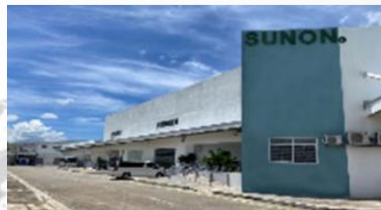
Bataan, Philippines I Fan & Module
